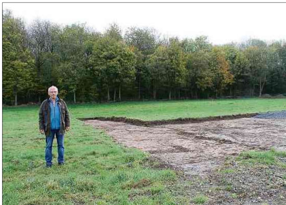
Die ersten Schritte sind gemacht: Senel Furtana wartet nur noch auf die Baugenehmigung für den neuen Standort der Jugendfarm Wilhelmshof. Sobald sie vorliegt, können die Bauarbeiten hier beginnen.
